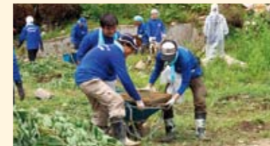
瓦礫の撤去作業
